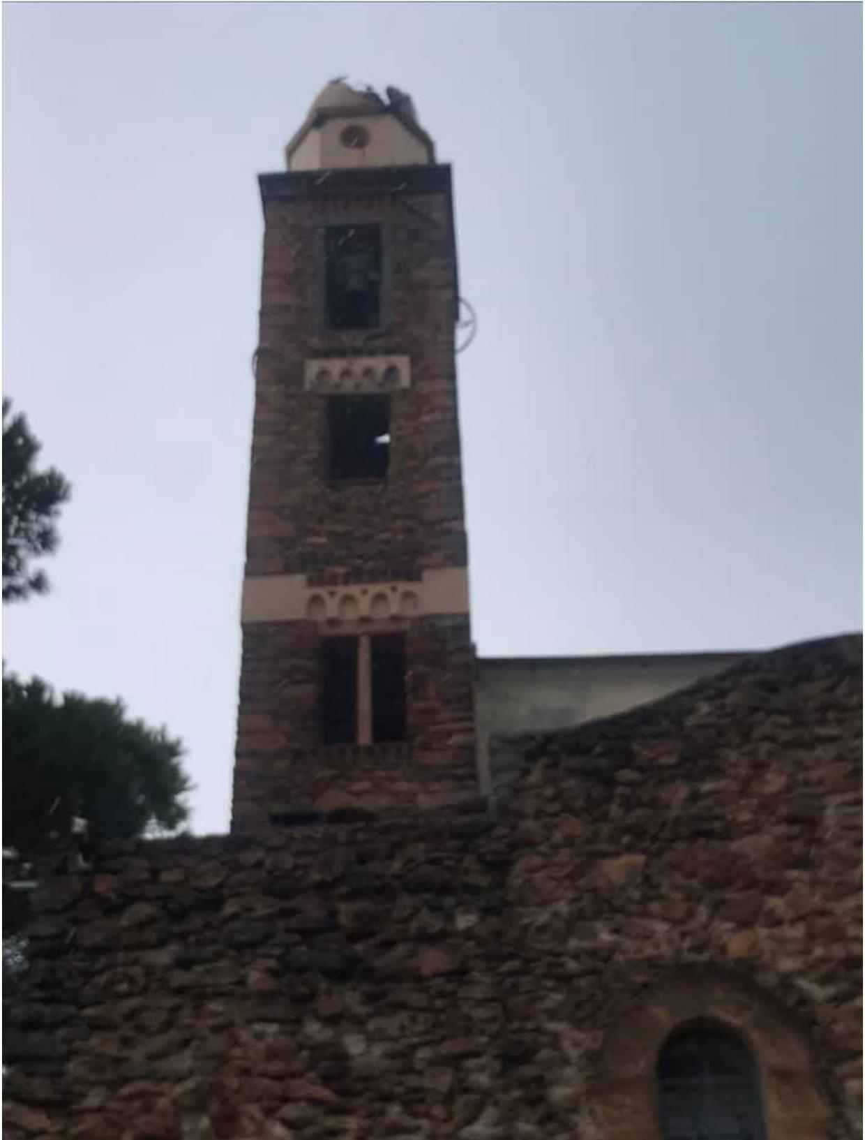
La scarica ha causato il cedimento di una parte del cupolino e, inoltre, ha causato un blackout elettrico e telefonico nell'intera zona.
