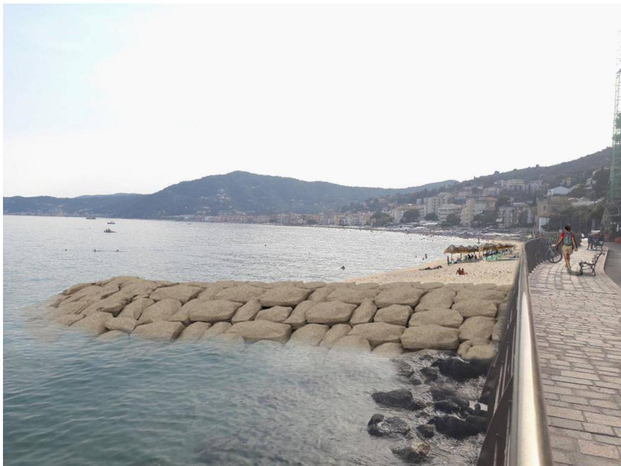
Il progetto consiste nella realizzazione di un pennello in massi rocciosi della lunghezza di 50 metri formato da due parti continue ma di diverso orientamento. Il primo tratto è radicato a terra con direzione nord - sud, il secondo è in direzione nordest-sudovest. La testata del pennello si troverà alla profondità di circa 2,30/ 2,40 metri e sarà in grado di intercettare la gran parte della sabbia erosa dal litorale.
