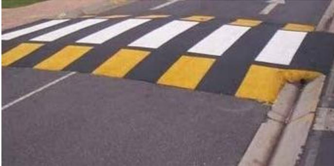
**Cosseria.** In frazione Case Lidora terminati oggi i lavori per due nuovi attraversamenti pedonali rialzati, uno di fronte al Centro Sociale e uno a fine rettilineo in direzione Carcare. Con quello realizzato ad ottobre 2017 finalmente i pedoni possono bypassare l'ex strada statale ora SP 28 bis con maggiore sicurezza.
