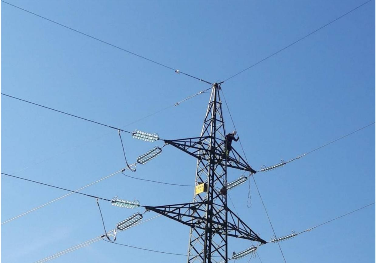
**Pietra Ligure.** Restyling per le linee dell'alta tensione elettrica nel ponente savonese: si tratta di attività di manutenzione pianificate, che prevedono la sostituzione dei conduttori, delle fune di guardia e degli armamenti.
