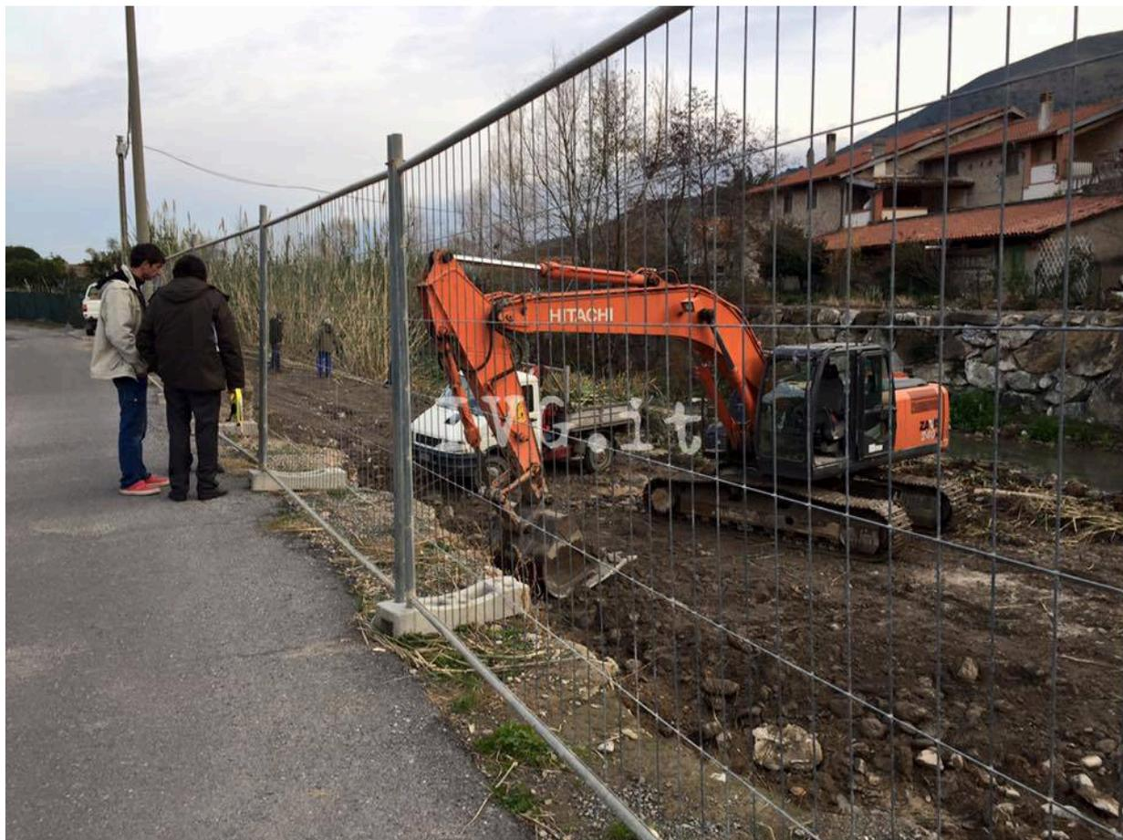
Ancora, verranno effettuati interventi di manutenzione ordinaria volti a ridurre il rischio idraulico cui è esposta l'area. Questi consisteranno nel taglio delle canne che occupano le sponde e nella riprofilatura della savanella per circa 200 metri tra il ponte medioevale e località Pizzalotto.
