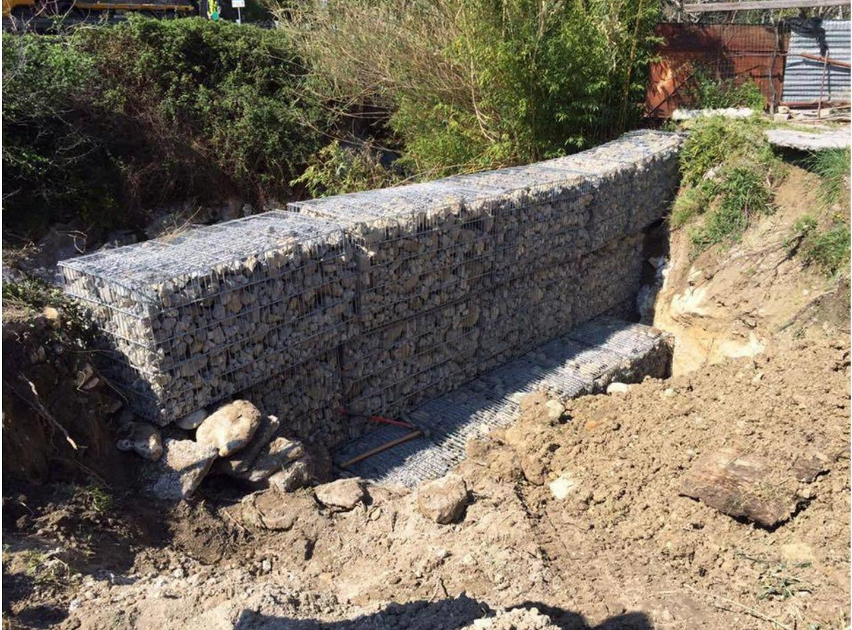
**Toirano.** Sono stati ultimati in questi giorni, a Toirano, i lavori di pulizia del torrente Varatella e del Rio Barescione e gli interventi di sistemazione idraulica degli argini crollati mediante la realizzazione di scogliere, muri in calcestruzzo e pietra e gabbionate.
