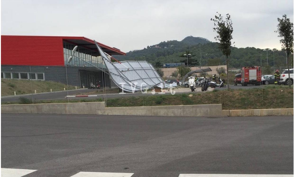
**Villanova d’Albenga.** Crollo all’interno dello stabilimento di Villanova d’Albenga di Piaggio Aerospace: **la copertura del parcheggio moto ha ceduto e si è abbattuta al suolo**, senza fortunatamente causare feriti.
